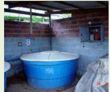
Recomenda-se fazer um buraco revestido de alvenaria de modo que se possa entrar e trabalhar com conforto e rapidez. A cobertura deve ser de telha de barro para manter o ambiente para a solução o mais fresco possível.
